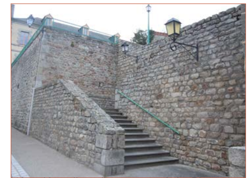
12 volées d'escalier menant à la Place Jean Moulin depuis la rue Barraud
