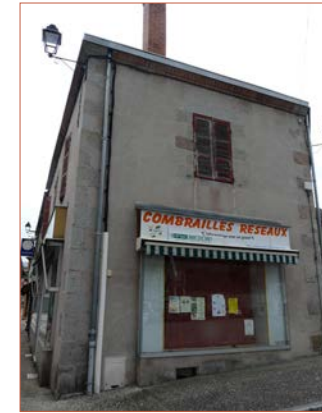
26 Bâtiment présent pour accueillir la station des services publics
