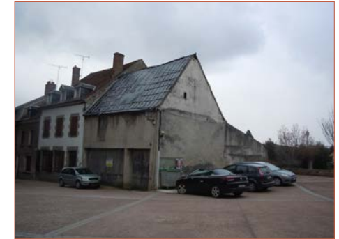
2 Place Jean Moulin angle du bâtiment «Clidière»
