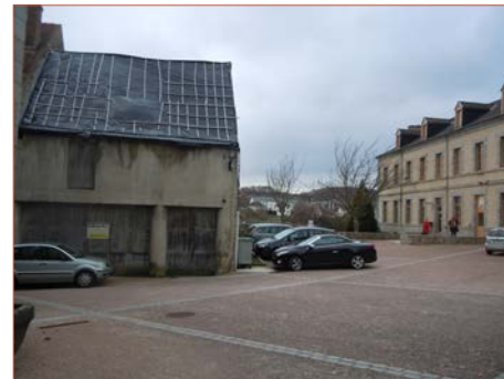
3 Place Jean Moulin angle du bâtiment «Clidière»
