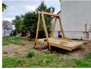
Publié le : dimanche 8 décembre 2024 CHANTIER OUVERT DE LA TYROLIENNE - JUILLET-DÉCEMBRE 2024 Tyrolienne du tramway 1 RUE JULIETTE DODU À MONTREUIL-SOUS-BOIS (93100)
