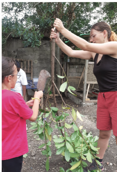
Préparation des bouts de bois pour les palençons et des branches pour le clayonnage.
